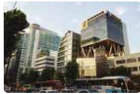
窓ガラスの占める割合が高いビル
